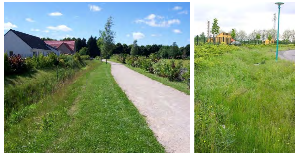
Exemples de noues, plus ou moins entretenues, permettant d'infiltrer les eaux pluviales tout en ayant un rôle paysager.
